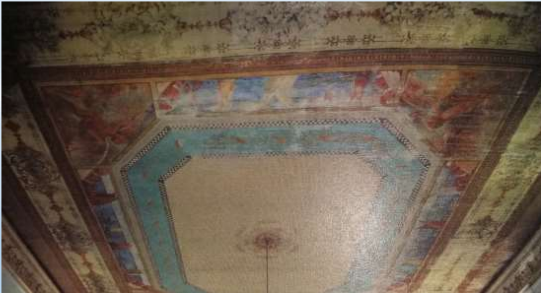
Particolari del soffitto
